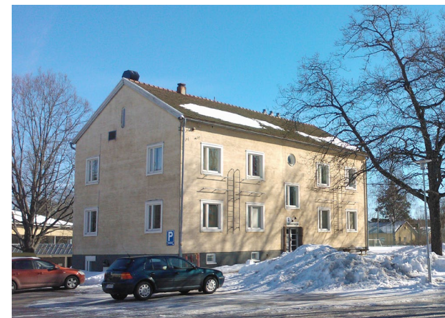
Asuntolakäytössä olleet 1940-luvun rakennukset muutetaan takaisin asunnoiksi.
